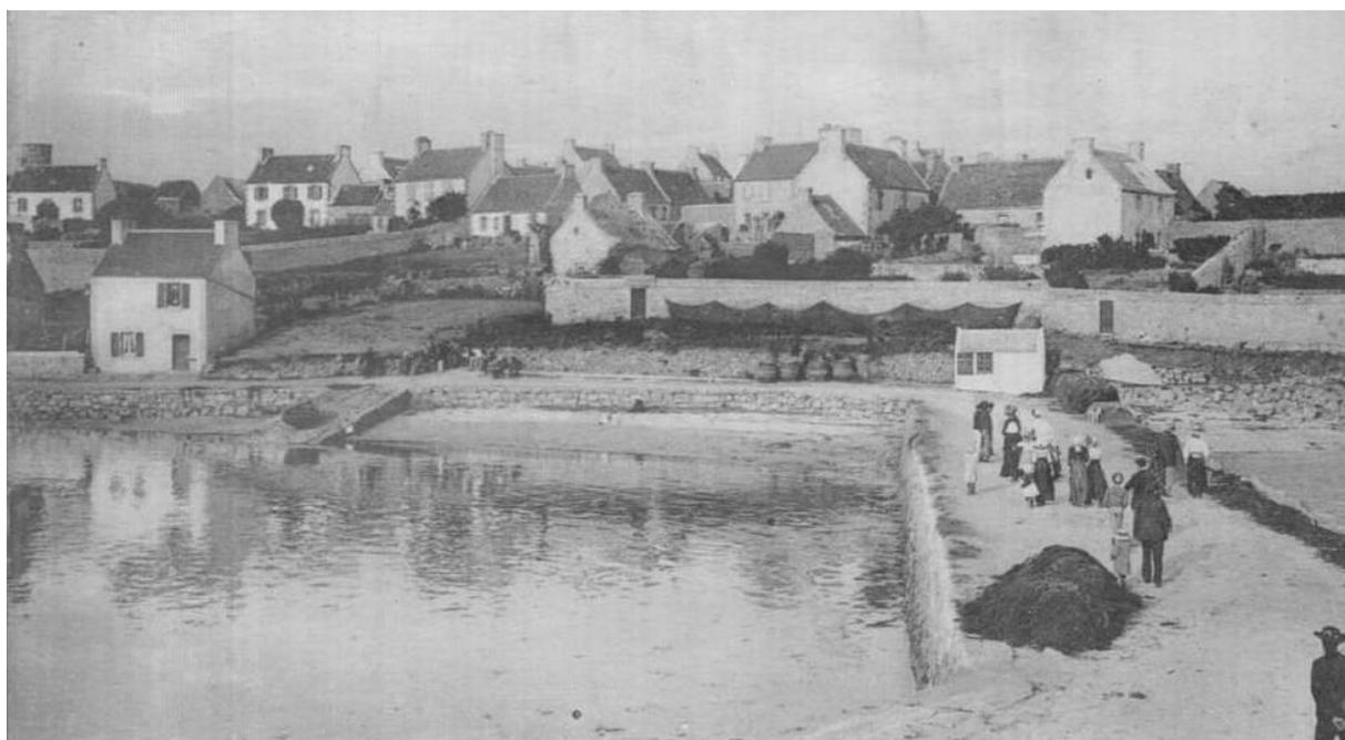
Vers 1900, le môle est déjà d'une bonne largeur. A la hauteur de 10.20m par rapport au 0 des cartes il n'est pas submergé par les grandes marées
