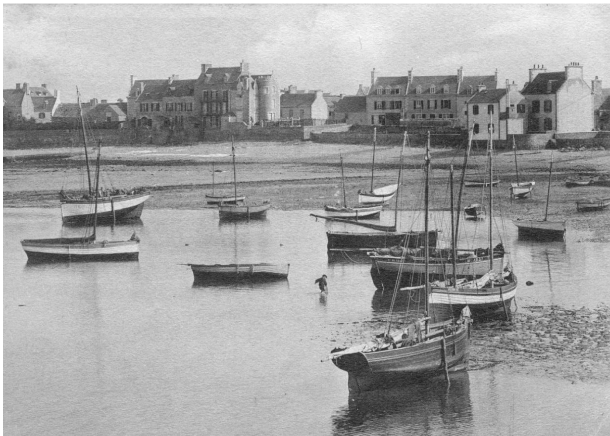
Photo de la collection Villard de la même époque la chaloupe grée en dundée est bordée à clins
