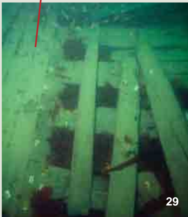
Lumières pratiquées sur le vaigrage du flanc tribord de l'épave.
