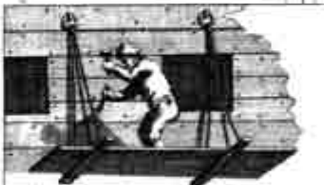
Fig. 135 et 136. L'ancrage d'anneaux sur la muraille du navire offrait de nombreuses utilisations, telles que le nettoyage des carènes et la fixation des canons aux sabords. Röding 1793, pl. LXII
