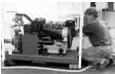
Mise en route de la motopompe à gros débit par Serge le Louet.
