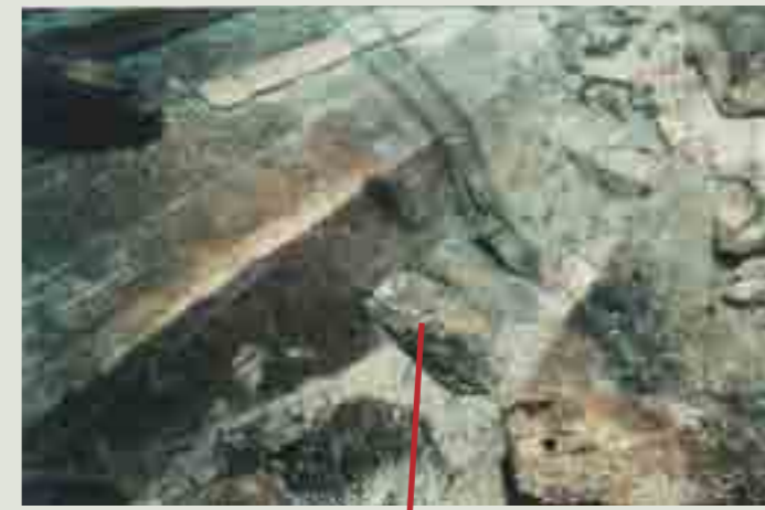
Fig. 11. Détail de la lumière pratiquée dans le vaigrage. La planchette couvrant la membrure a été déposée.
