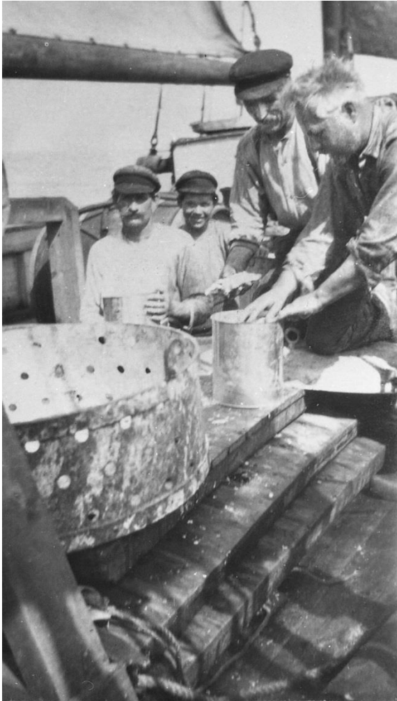
« Mise en boîte du thon séparé des écailles et des arêtes, les boîtes contiennent 10 kg de poisson »
