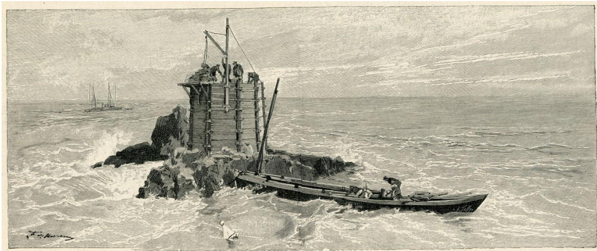
Construction de la tourelle de la Horaine deux embarcations le long de la roche et le vapeur croise à distance (l'illustration coll perso)
