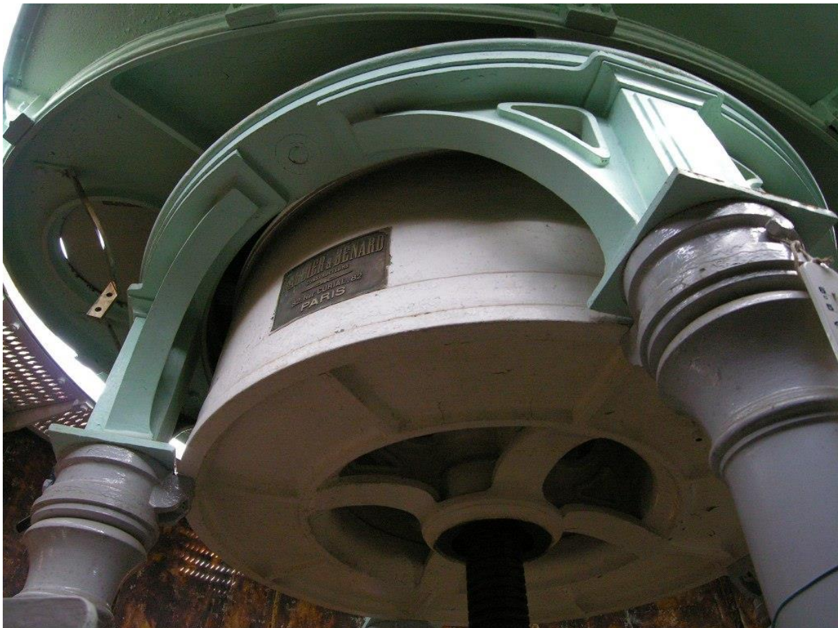
Cuve de mercure sur laquelle flotte le dispositif d'éclairage qui peut par conséquent tourner avec des frottements réduits (photo Phares et Balises Brest)
