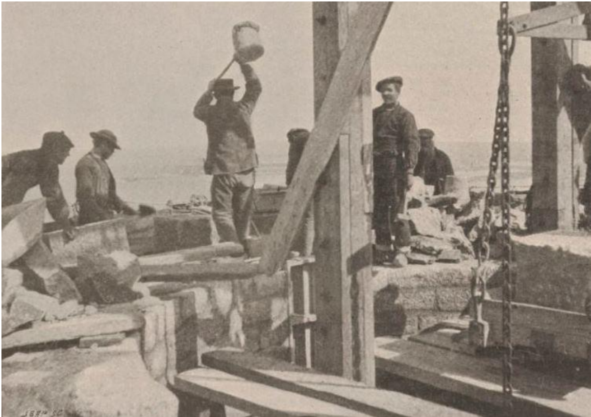
Les travaux à 45 m de hauteur en 1899, la tour creuse avec son escalier les parements sont en pierres de taille le rempli est de moellon et mortier, un ouvrier avec une masse en bois frappe une pierre pour la positionner
