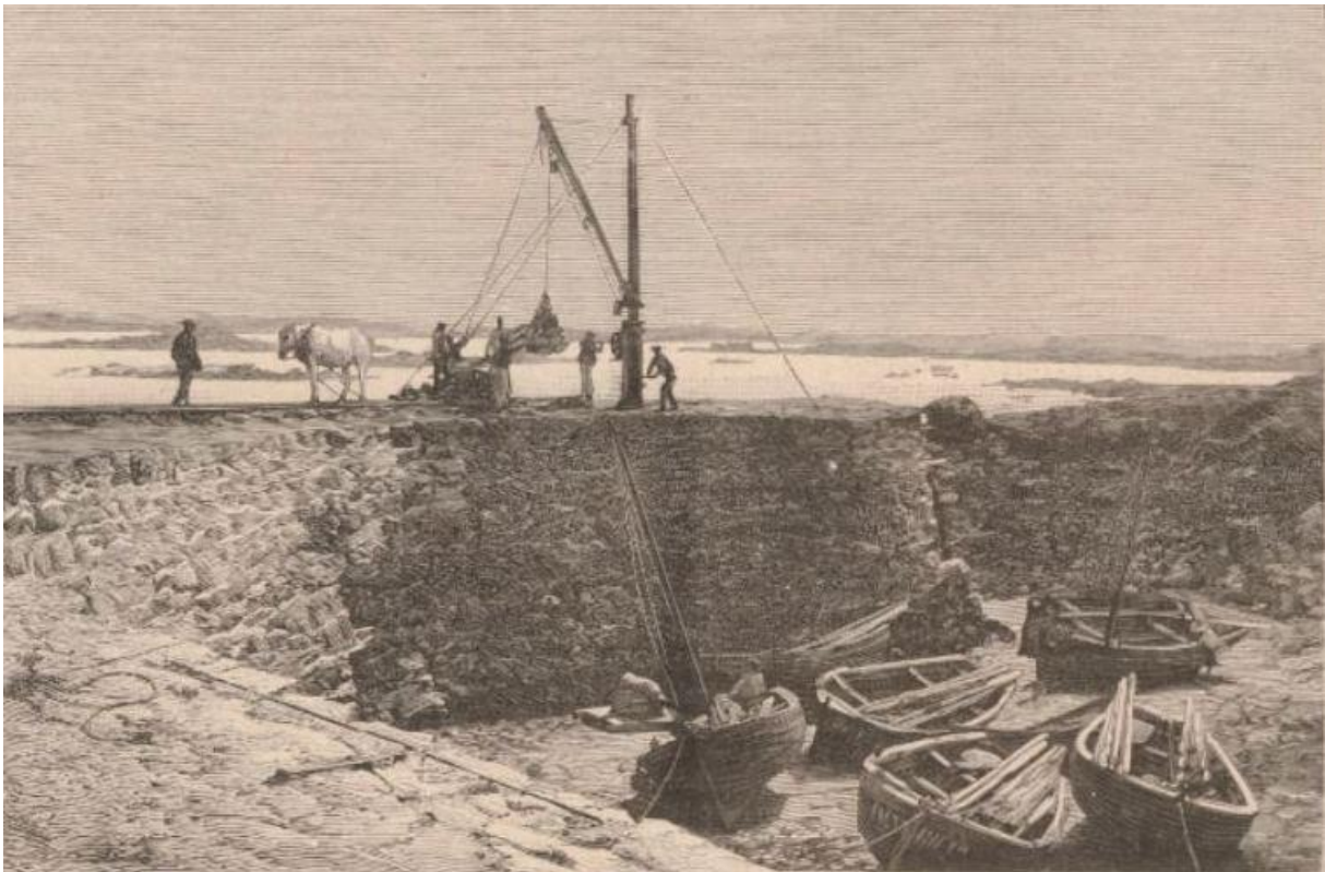
Petit port de l'île Vierge, avec le mât de charge et le treuil à main pour le débarquement des matériaux et les canots pour ramener les manœuvres à Plouguerneau
