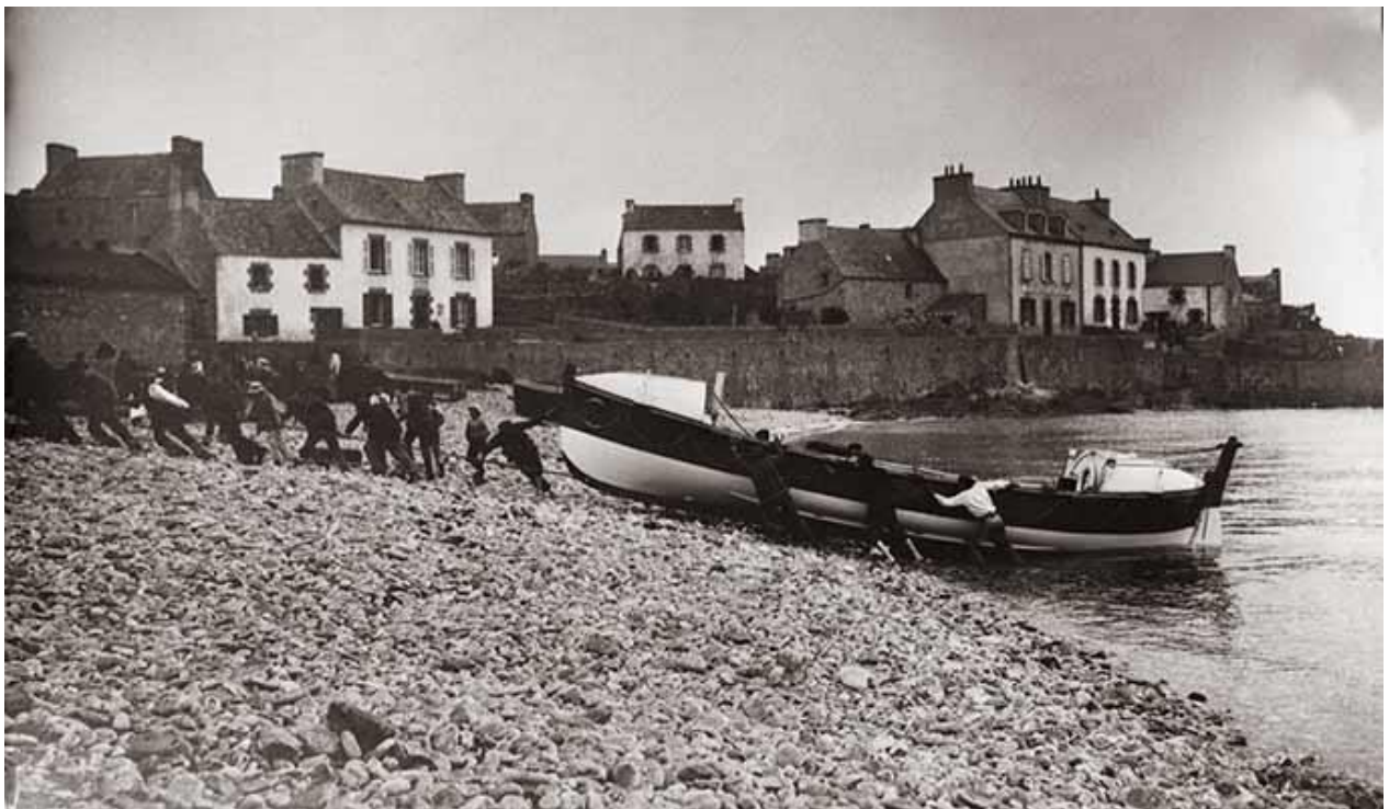
Canot de sauvetage Amiral Roussin remontant dans son abri dans le port de molène. Le canot construit en 1894 au havre au chantier Augustin Normand est du modèle 10.10m à redressement
