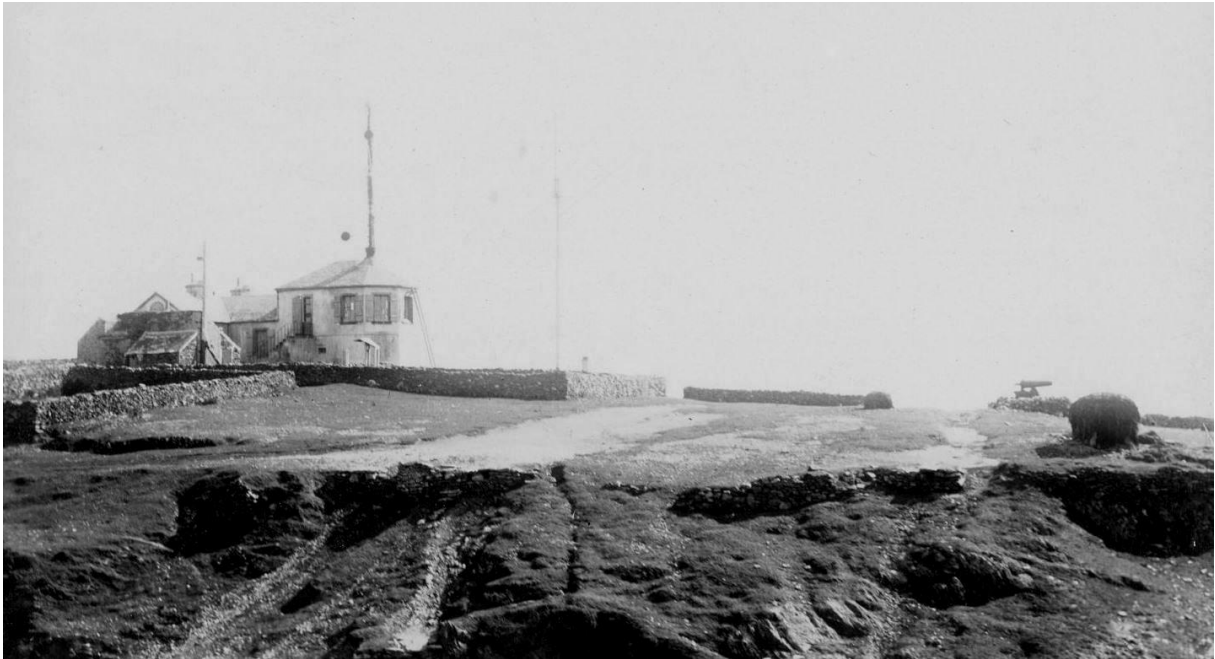
L'ancien sémaphore de la pointe Saint-Mathieu, à Plougonvelin la chambre de veille est plus haute que sur le plan type, on aperçoit sur la droite le canon d'alarme , une ancienne caronade
