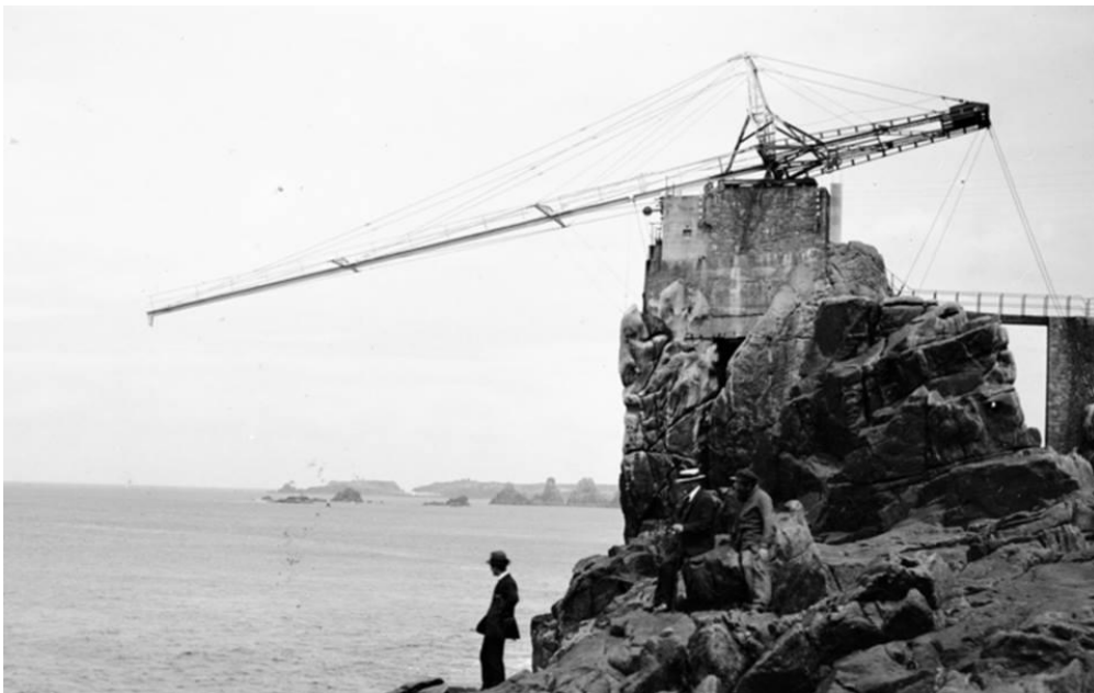
De 1912 à 1919, sur ce rocher, sur une embase une espèce de grue métallique. Cette structure servait à suspendre une cloche sous-marine, mais à quoi servait elle ? (photo capitaine Octave Longuet)
